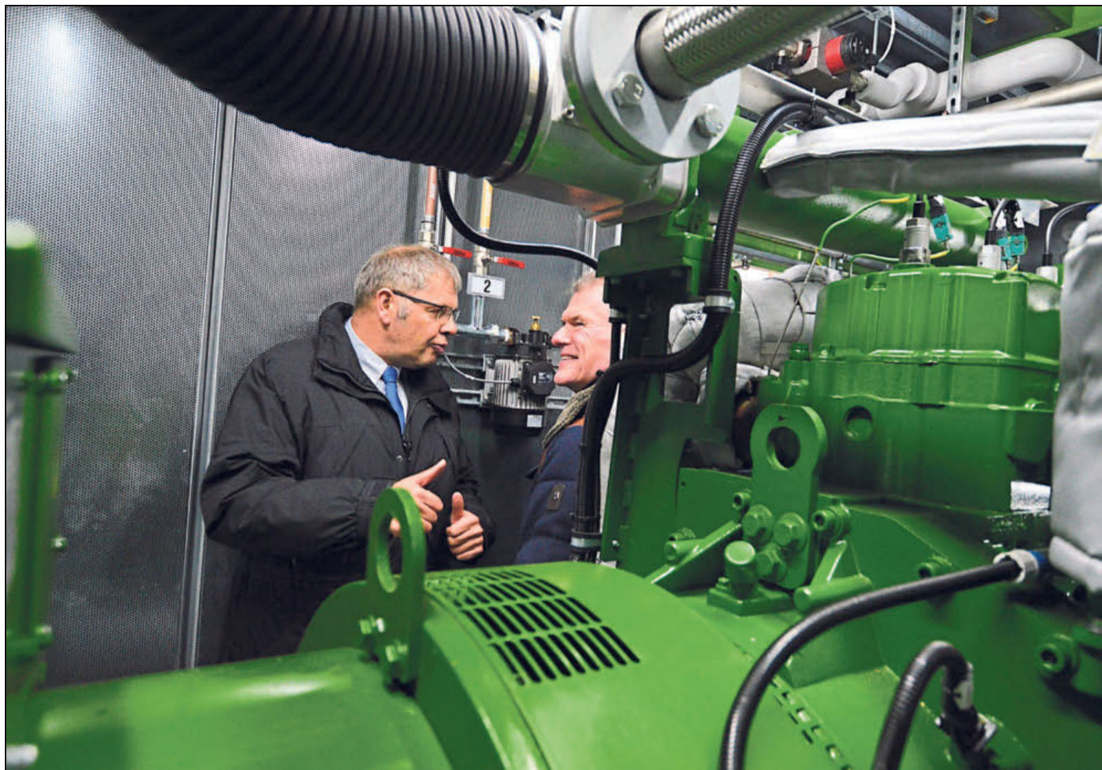
Karlгүйter Eggersmann (links) und Kreisdirektor Ralf Heemeier besichtigen die neue Kompotec-Anlage an der Dornbreede. Theoretisch können mit der aus Bio-Abfall entstehenden Energie etwa 350 Haushalte versorgt werden. Fotos: Jan Gruhn
